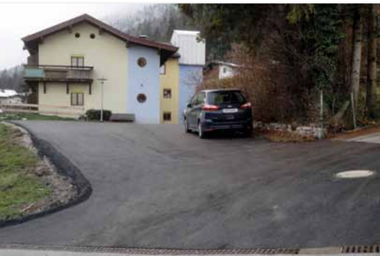
Parkplatzerweiterung Ostseite Altersheim
