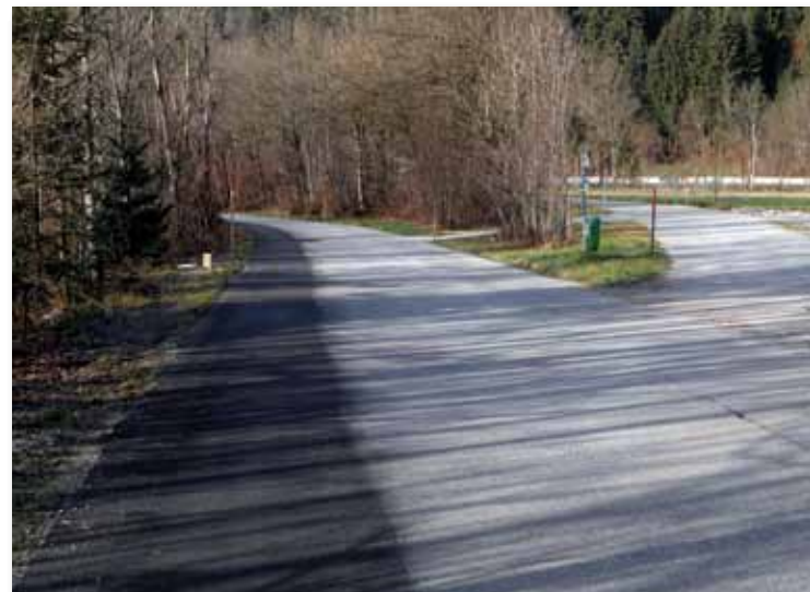
Sanierung in der Innschleife Richtung Angath
