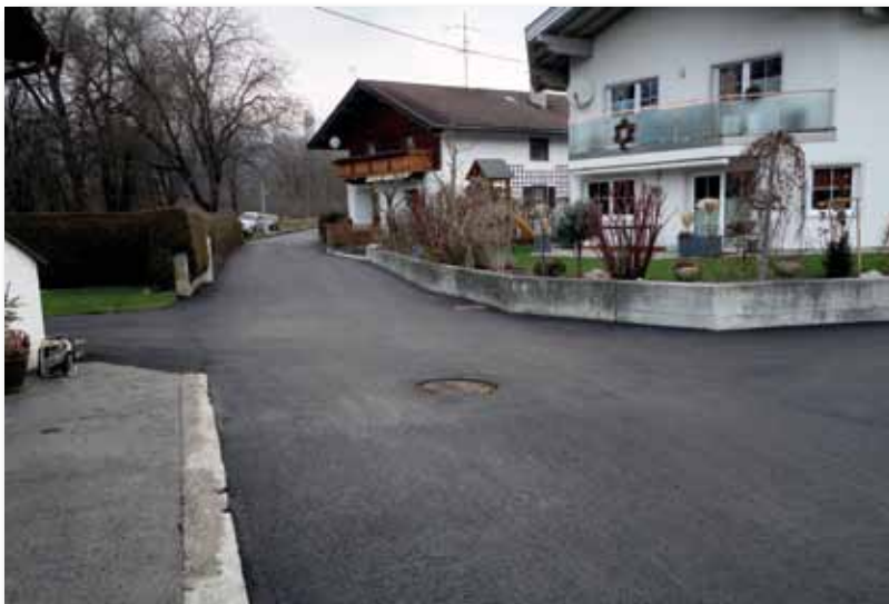
Oberflächenentwässerung und Sanierung Innstraße
