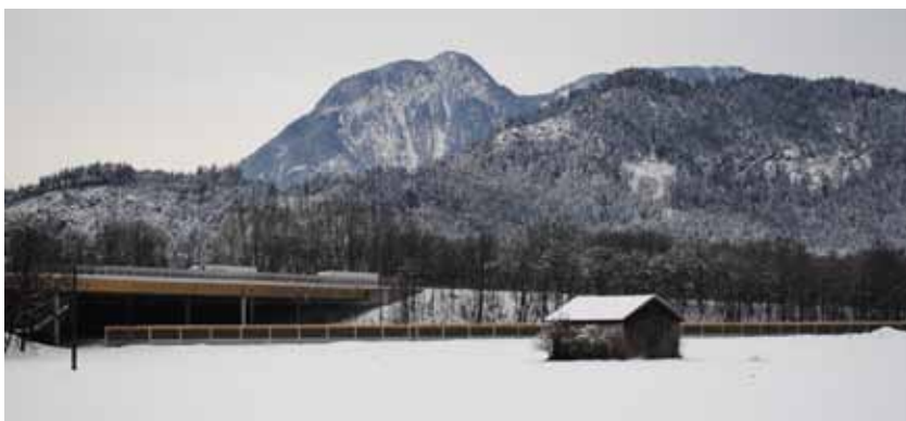
Die neu gebaute Lärmschutzwand im Bereich Stimmersee/Au
