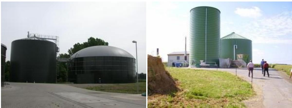
Abbildung 25: Fermenter in Stahlbauweise
