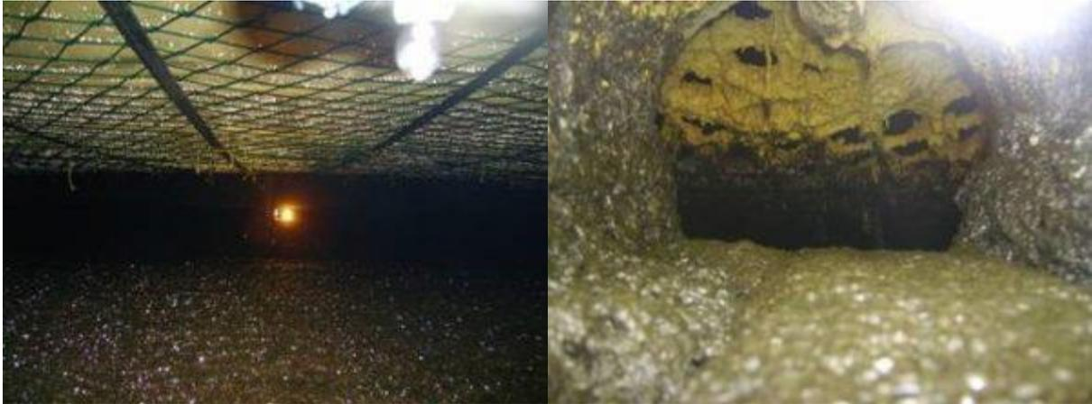
Abbildung 31: Innenansicht Fermenter mit Entschwefelungseinrichtung
