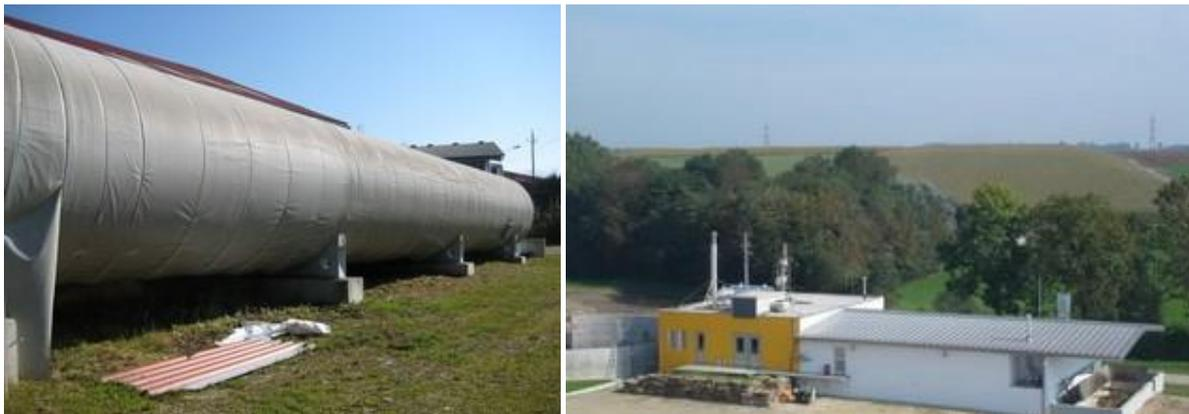
Abbildung 22: Rohreaktor Freiaufstellung und im Gebäude integriert
