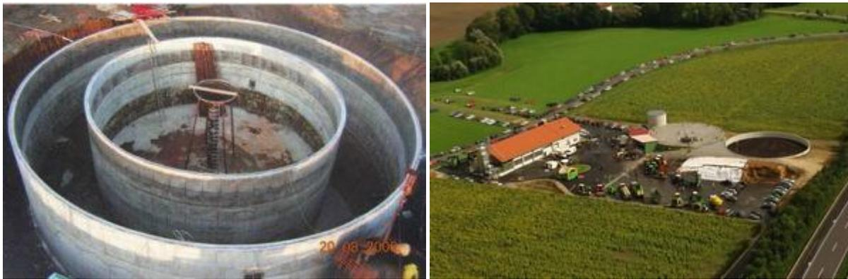
Abbildung 24: Fermenter freistehend, Ring-in-Ring-System
