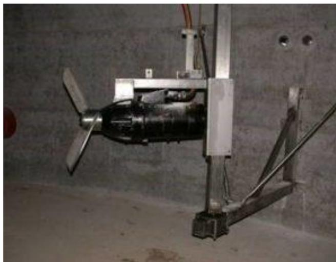
Abbildung 30: Tauchmotorrührwerk
